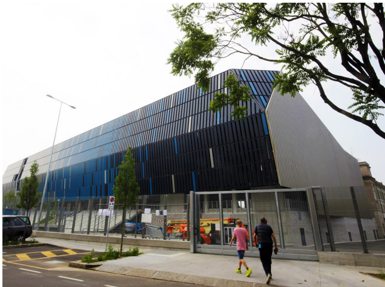
il nuovo rivestimento del settore nord lato tribuna centrale (F. Moro)
