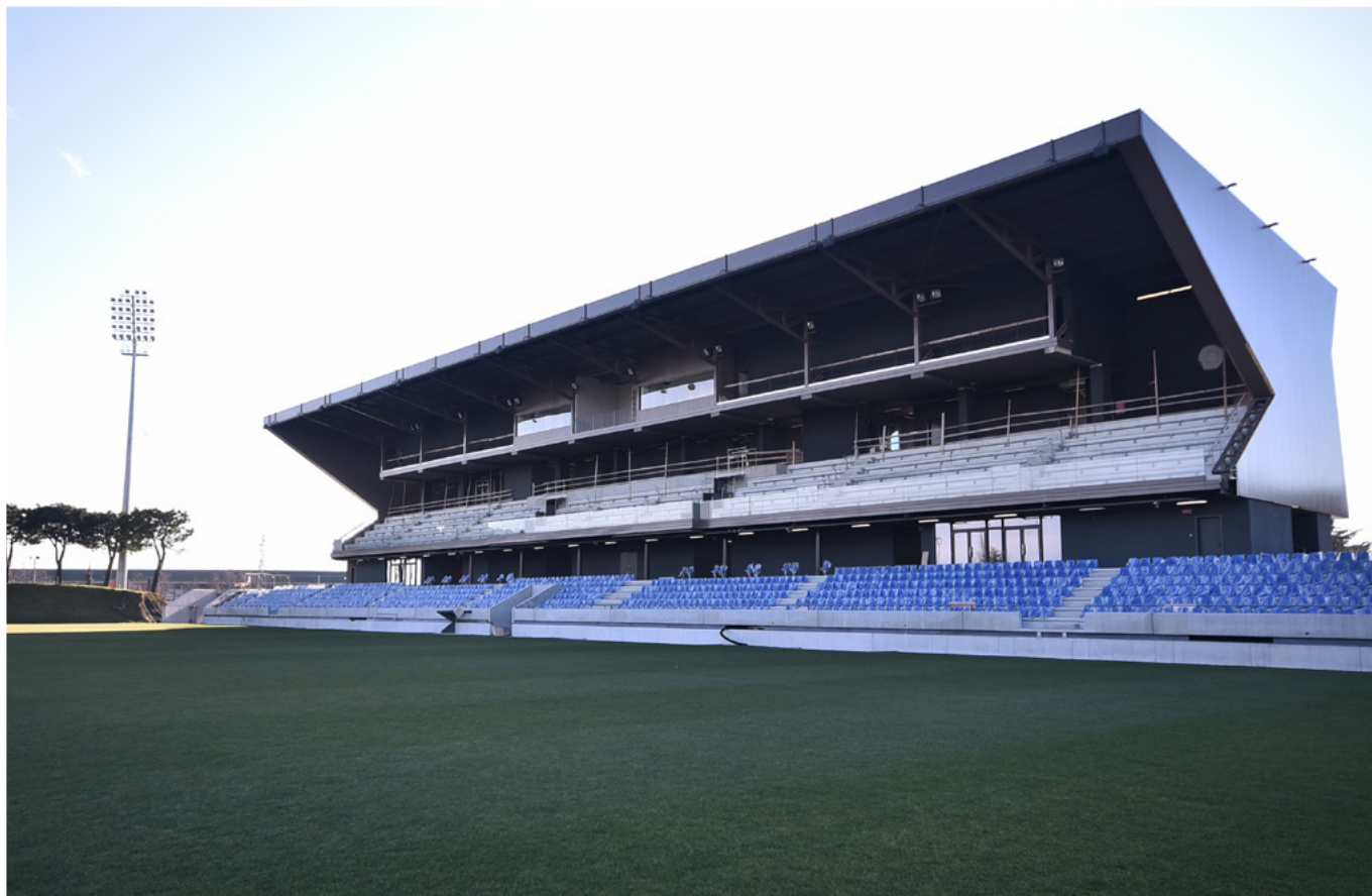
Lavori in corso della tribuna sul campo principale dell'impianto (credits: AlbinoLeffe).
