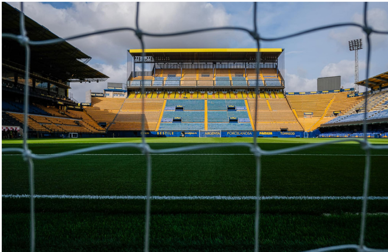
Un'immagine dello Stadio della Ceramica, così ribattezzato nel 2017 dopo averne rivestito la facciata di gres porcellanato (credits: Estadio de la Ceramica - F. C. Villarreal).
